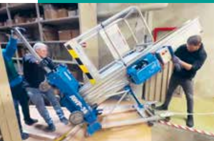
Die bedienbare Hubarbeitsbühne wird hinabgelassen.
