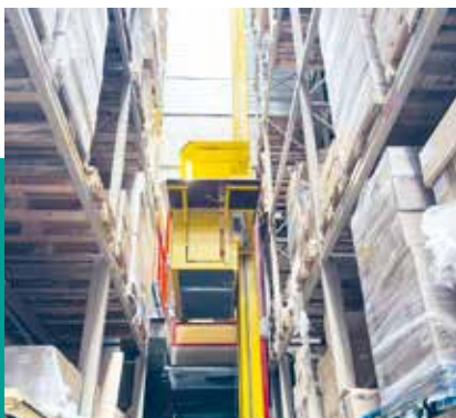
Eines der drei Regalbediengeräte
